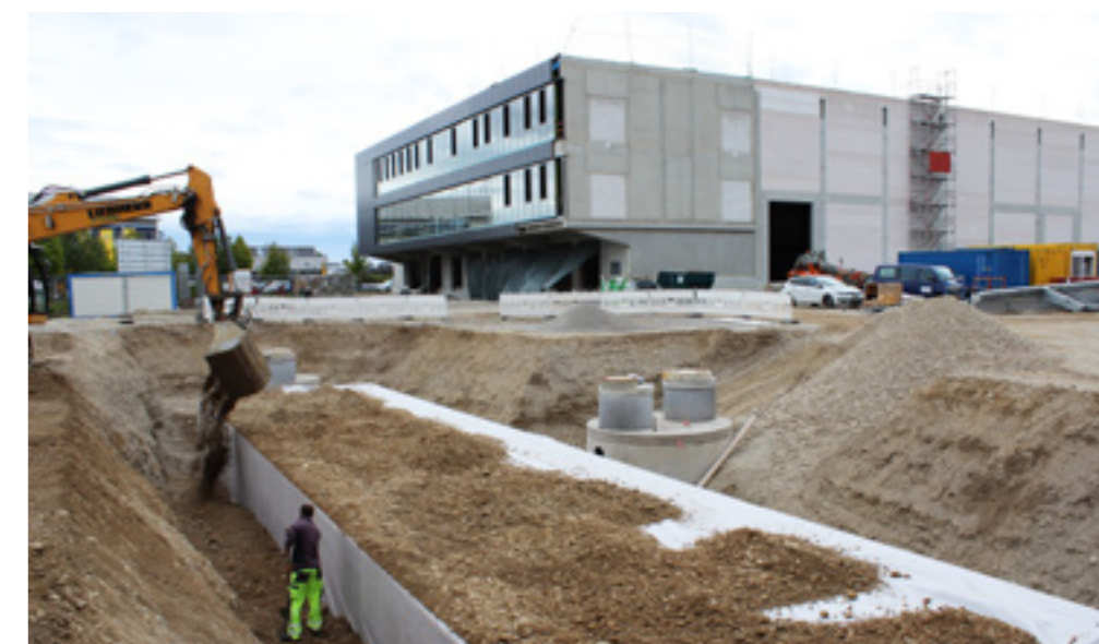
Mit der ausgeführten Erdüberdeckung von 120 cm bis Oberkante Gelände ist das Rigolensystem bis SLW 60 überfahrbar.
