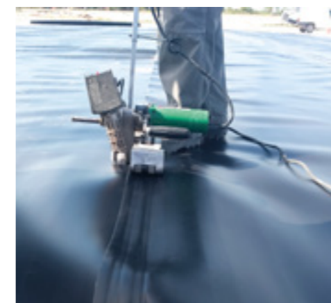
Der Rigolenkörper wurde mit einer HDPE-Folie verschweißt
