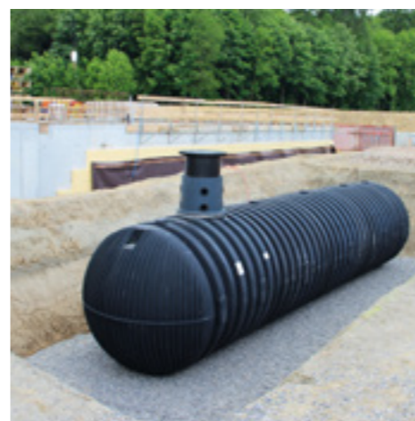
Die Konstruktion des Behälters sorgt für hohe Stabilität und ermöglicht so den Einbau bis zur Tankmitte in das Grundwasser. Der Carat XXL ist für eine Lkw-Befahrbarkeit mit bis zu 40 t Gesamtgewicht ausgelegt.
