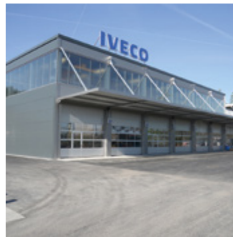
Der neue Standort der Iveco Filiale in Hendschiken mit Lkw-Werkstatt und angegliederten Büros wurde vom Bauherrn SUVA konsequent nach dem Minergie-Standard geplant und gebaut.
