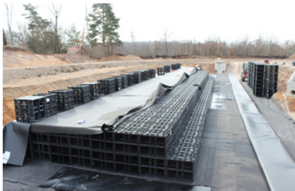
Der Rigolenkörper fasst rund 480.000 Liter Regenwasser
