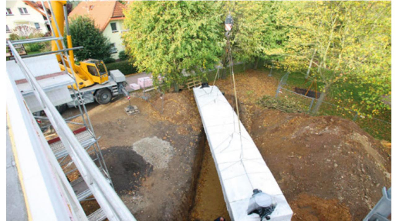
Werkseitig können eingeschweißte Rigolen bis zu einem Volumen von maximal 60 m³ produziert und per Lkw zum Einsatzort transportiert werden.
