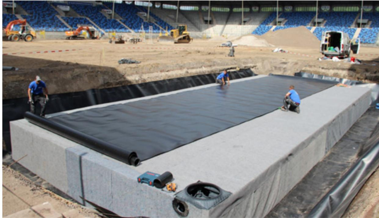
Der Behälteraufbau vor Ort bietet die Möglichkeit Länge, Breite und Höhe der eingeschweißten Rigolen objektspezifisch zu wählen. Insbesondere bei
