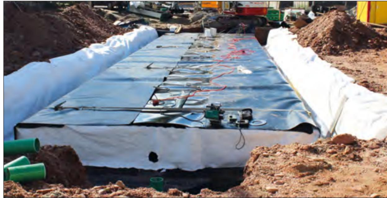
Der Retentionsaufbau vor Ort bietet die Möglichkeit Länge, Breite und Höhe der eingeschweißten Rigolen objektspezifisch zu wählen. Insbesondere bei vorgegebenen Baufenstern, die einen konventionellen Tankeinbau nicht ermöglichen,
