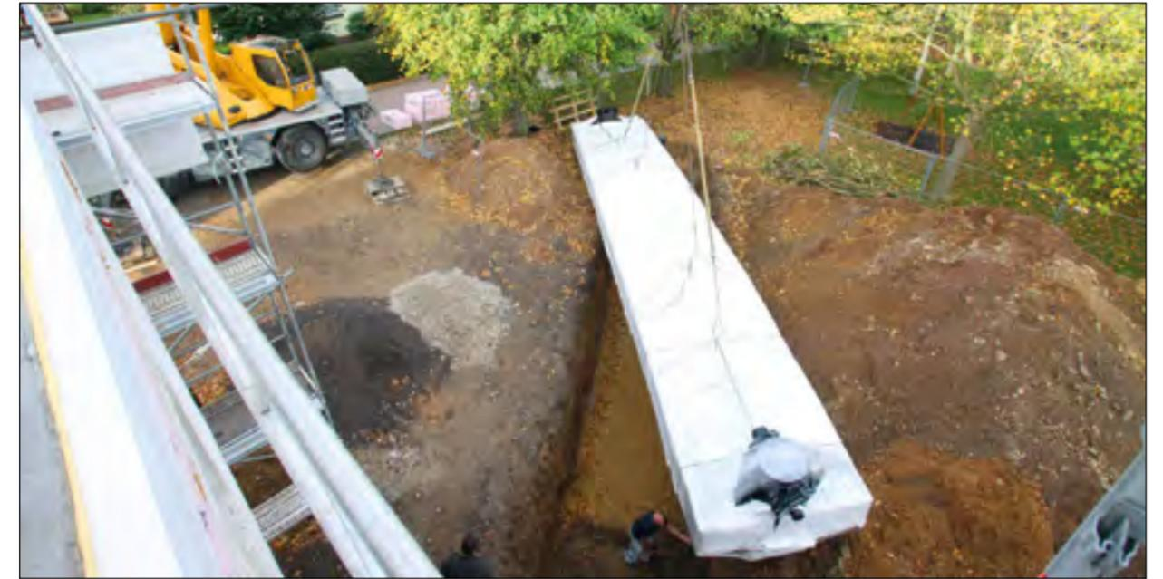
Werkseitig können eingeschweißte Rigolen bis zu einem Volumen von maximal 60 m<sup>3</sup> produziert werden und per Lkw zum Einsatzort transportiert werden. Die werkseitigen Rigolen lassen sich vorkonfektionieren und auf Grund ihres geringen
