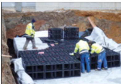
Industriegebäude, Tumeltsham (AT)
