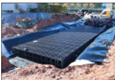
Mehrfamilienhaus, Gaggenau (DE)
